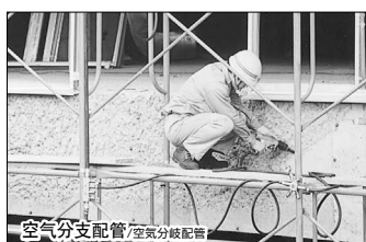
空气分支管/空気分岐配管
